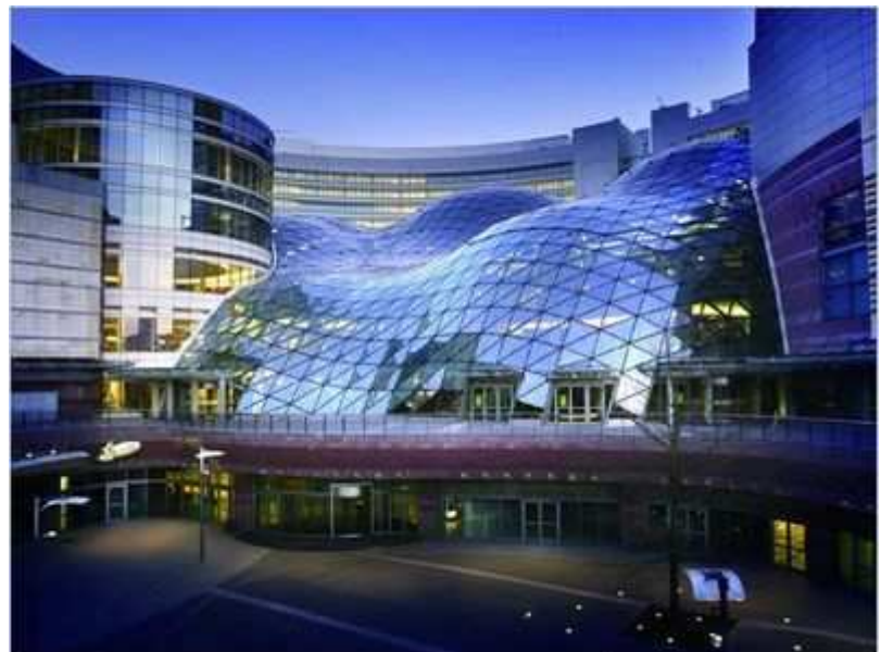
Verrière de l'Atrium Zlote Tarasy - AUTRICHE
