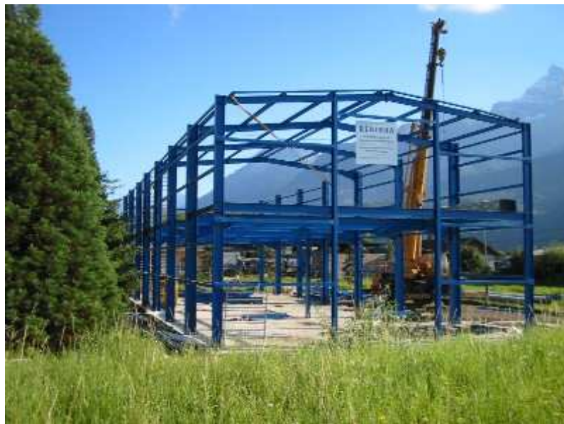
Photo : Une grue mobile
