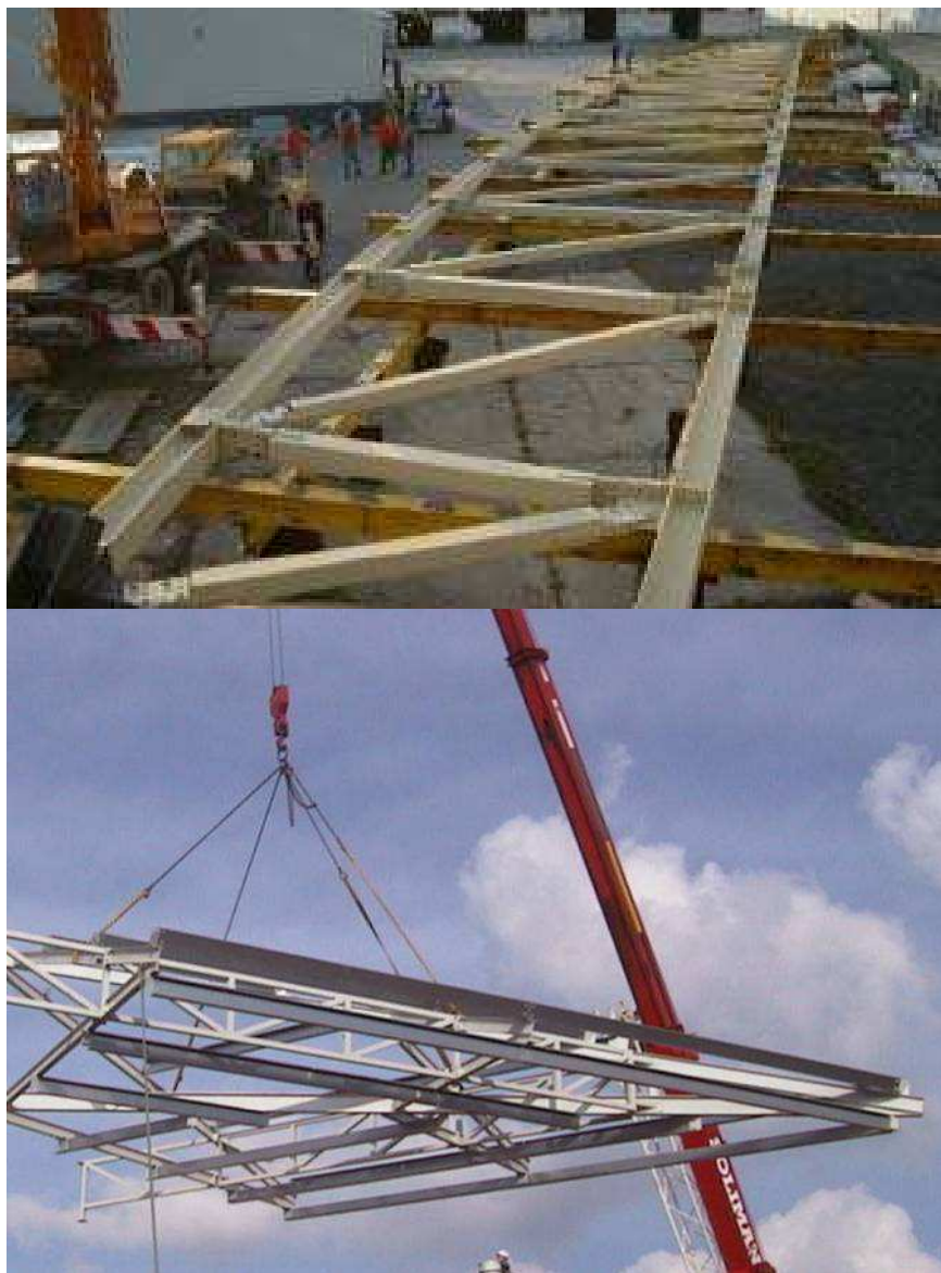
Préassemblage de structure
