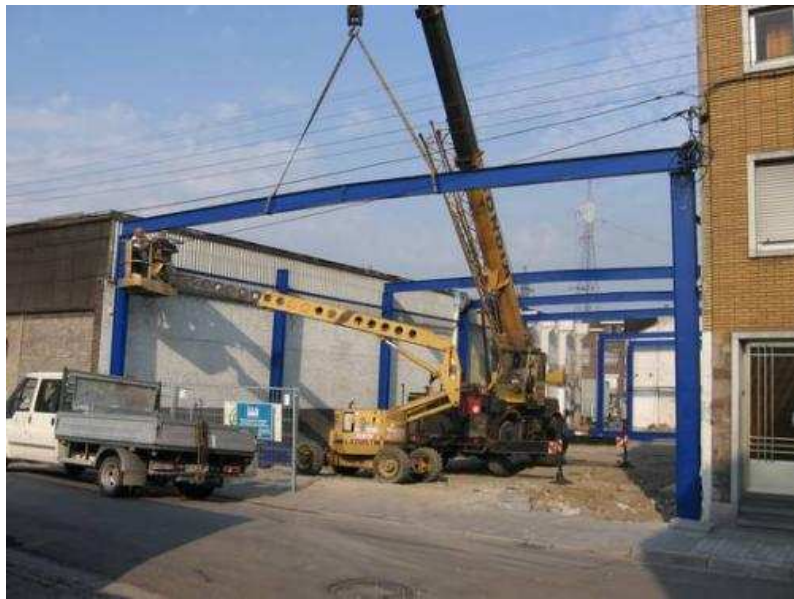
Mise en place et réglage d'une poutrelle
