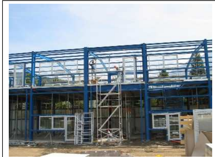
Photo : Un échafaudage
