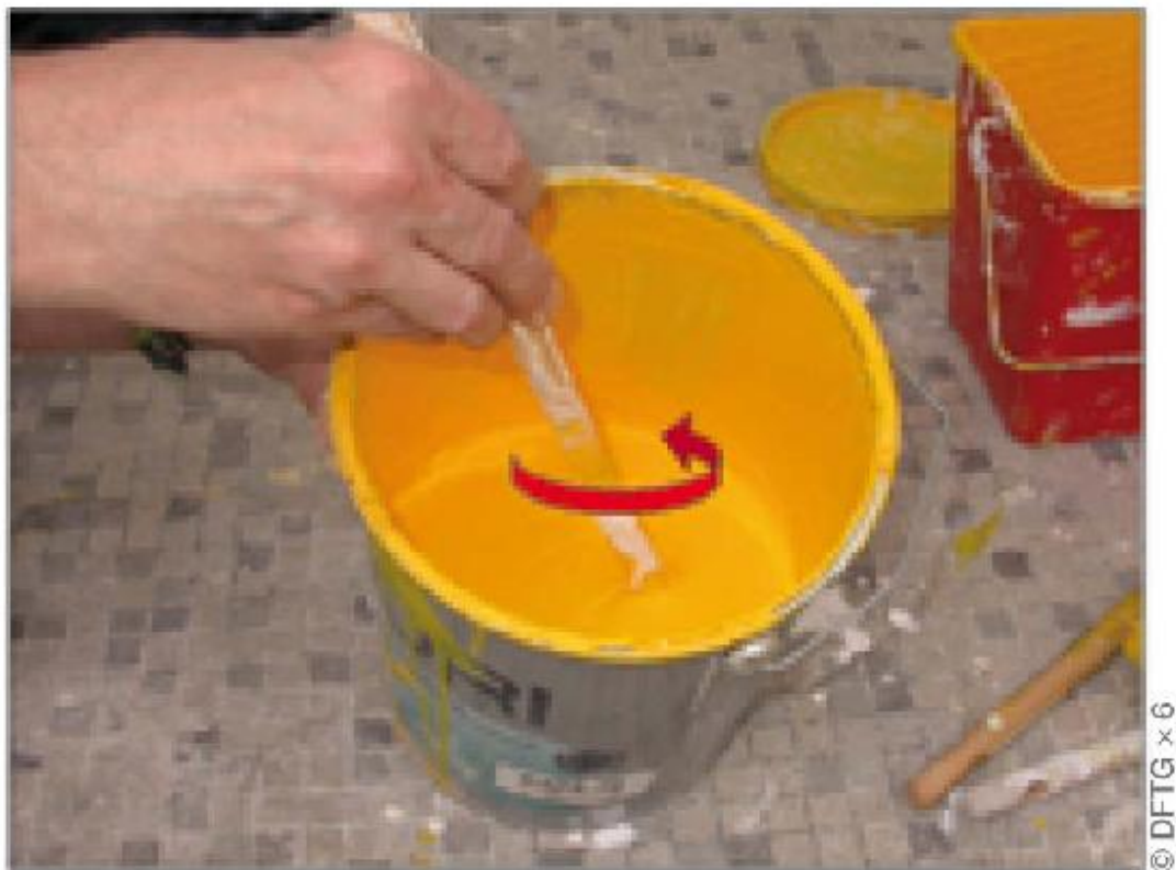
Figure 69 : Peindre un mur
