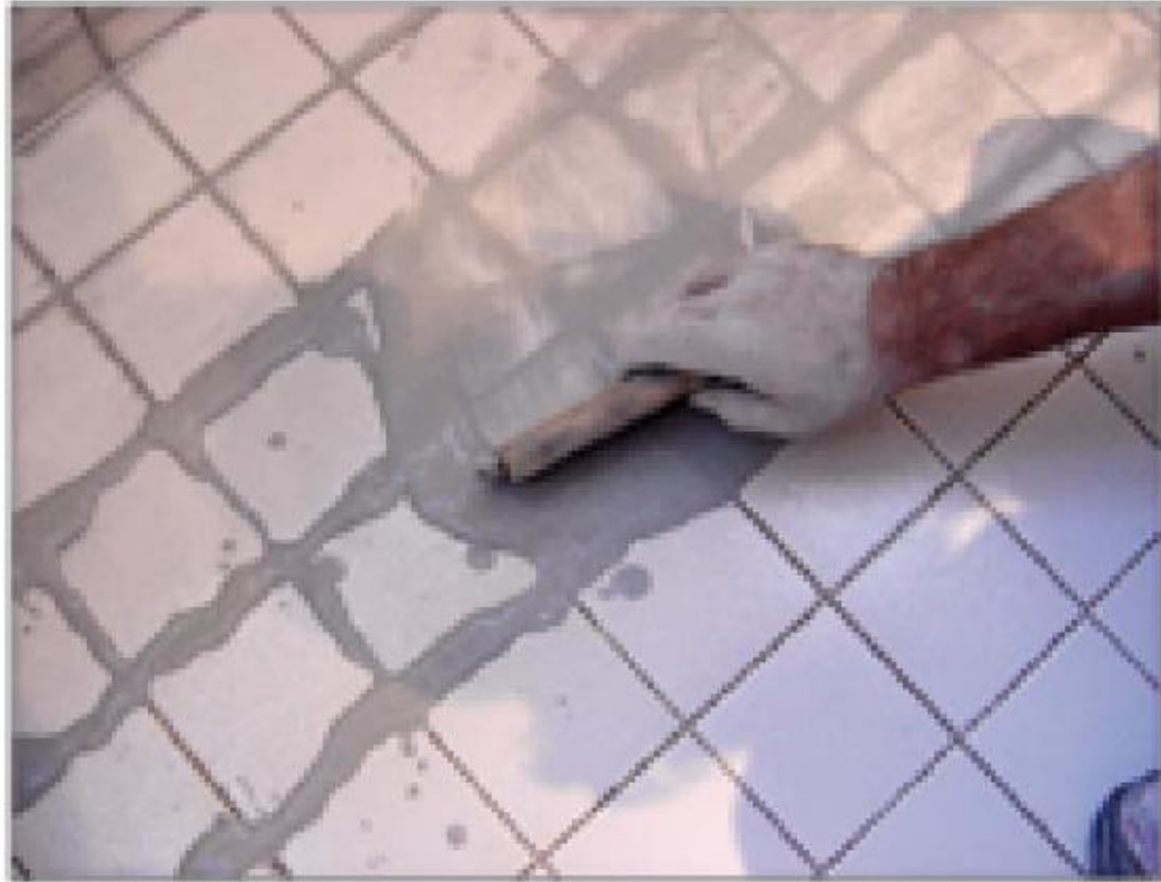
Figure 60 : La réalisation des joints de sol
